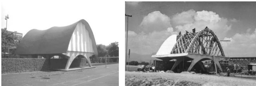
Figura 6: Pavilhão dos Raios Cósmicos (1951); Figura 7: Processo de moldagem da cobertura do pavilhão, onde pode se observar a composição regrada da superfície a construir.
